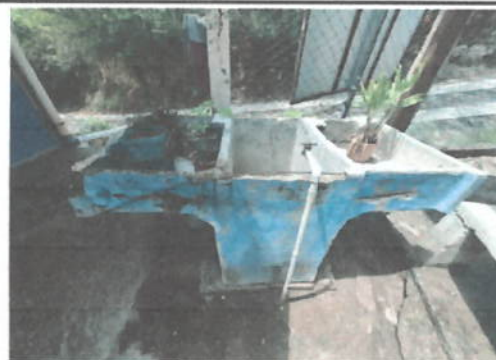
FOTO 4: REPARACIÓN O SUSTITUCIÓN DE ÁREA DE COCINA sustitución pila, nivelada y con conexiones hidráulicas.
