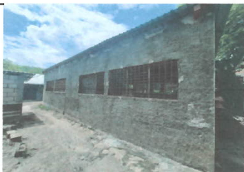
FOTO 5: REPARACIÓN DE REPELLO Y CERNIDO DE PAREDES
