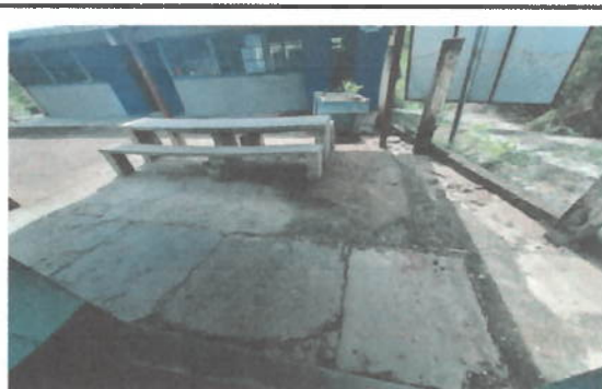
FOTO 4: LOSA DE PATIO
