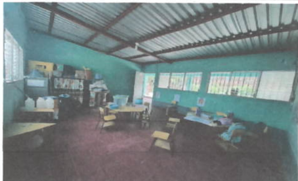
FOTO 1: PINTURA EN MUROS INTERIOR Y EXTERIOR
